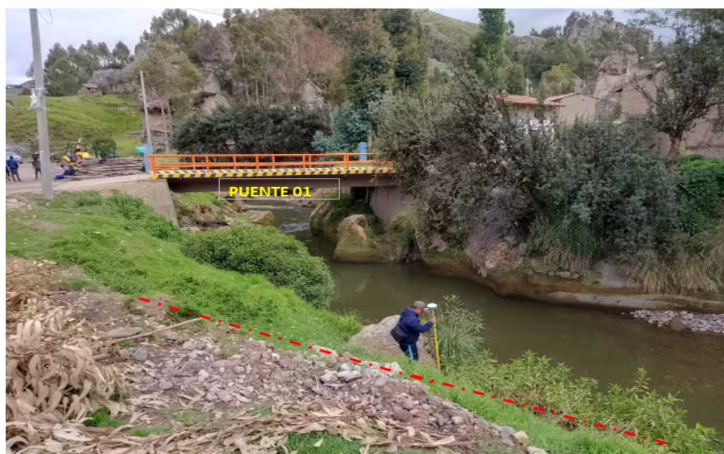
FIGURA N°03: TRAMO III, ESTADO CRITICO ANTE UNA EVENTUAL CRECIDA DEL RIO HUAYANAY QUE AFECTARIA A LA INFRAESTRUCTURA DE CENTRO DE SALUD, SE PLANTEA DLA CONTRUCCION DE MURO DE GAVIONES
