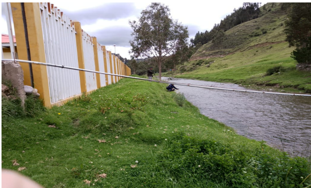
FIGURA N°03: TRAMO III, ESTADO CRITICO ANTE UNA EVENTUAL CRECIDA DEL RIO HUAYANAY QUE AFECTARIA A LA INFRAESTRUCTURA DE CENTRO DE SALUD, SE PLANTEA DLA CONTRUCCION DE MURO DE GAVIONES
