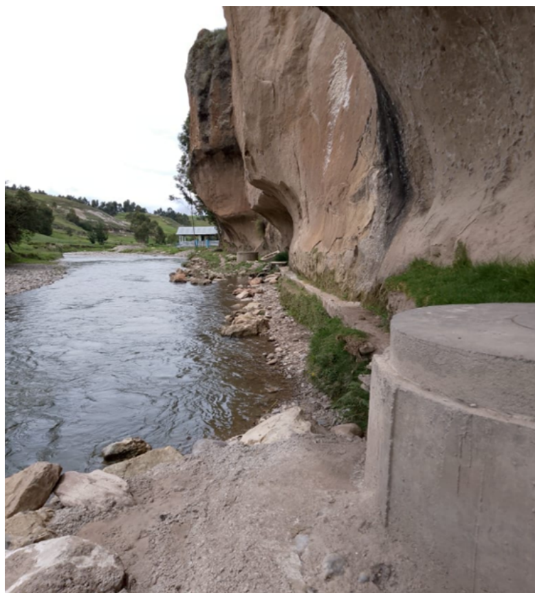
FIGURA N°04: TRAMO III, ESTADO CRITICO ANTE UNA EVENTUAL CRECIDA DEL RIO HUAYANAY QUE AFECTARIA A LA INSTALACION DE BUZONES Y TUBERIA DE AGUAS RESIDUALES QUE VAN HACIA EL PTAR Y ESTO OCACIONARIA DAÑOS E INTERRUPCION DE SERVICIO DE DESAGUE EN TODA LA C.P. DE HAYANAY
